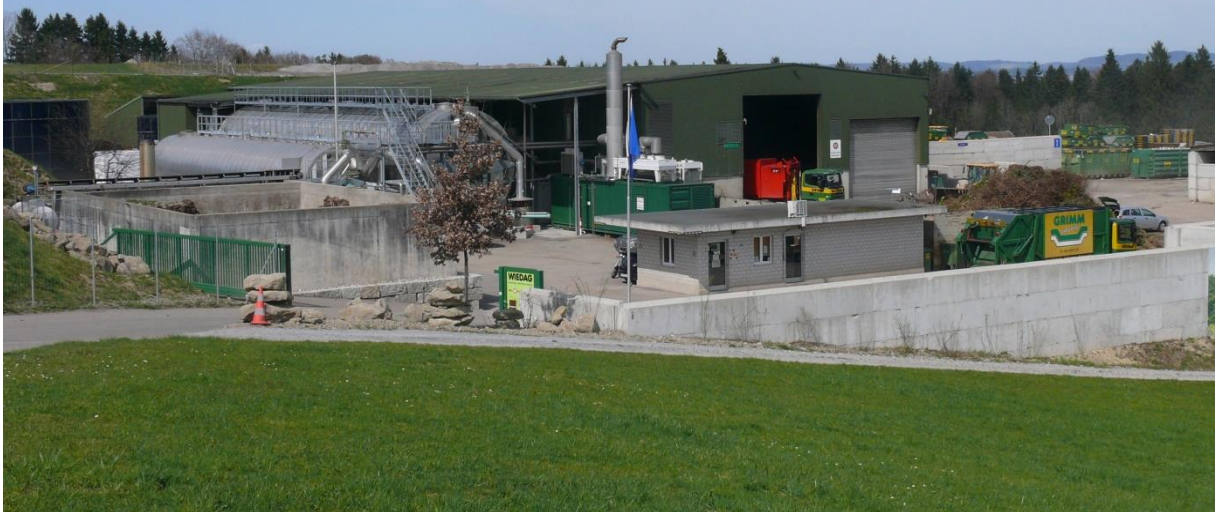
Gesamtansicht der Vergärungsanlage Chrüzlen
