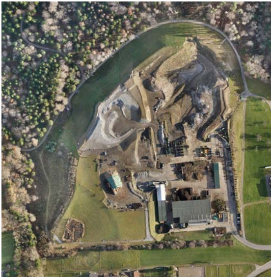
Heutiger Zustand der Biomasseverwertungsanlage und der offenen Deponie Chrüzlen
